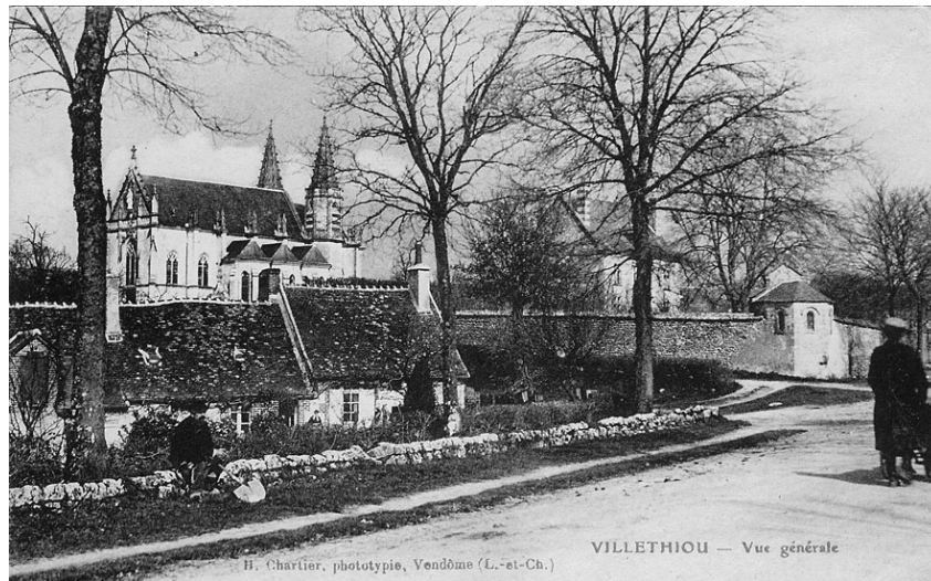
Vue générale sur le hameau et la chapelle de Villethiou
