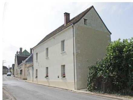
La maison désertée par les sœurs de la Providence accueillit provisoirement l'école publique de filles.
