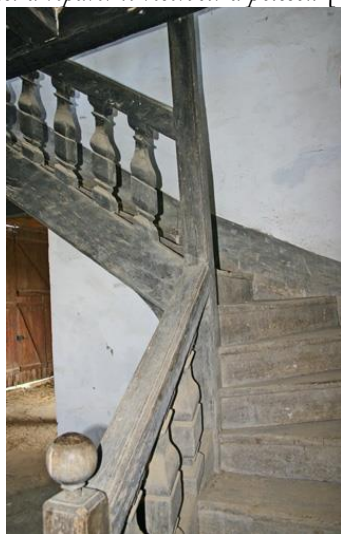
Départ de l'escalier à balustres et palier du premier étage
