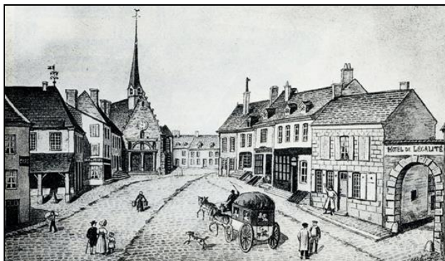
Le centre de Mondoubleau. À droite, l'entrée du siège du District (plus tard, hôtel du Grand Monarque).
