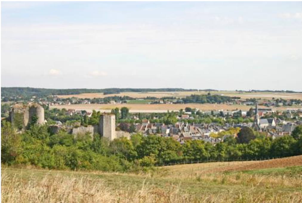
Vue générale de Montoire, entre le château féodal et l'église Notre-Dame de Pitié.
