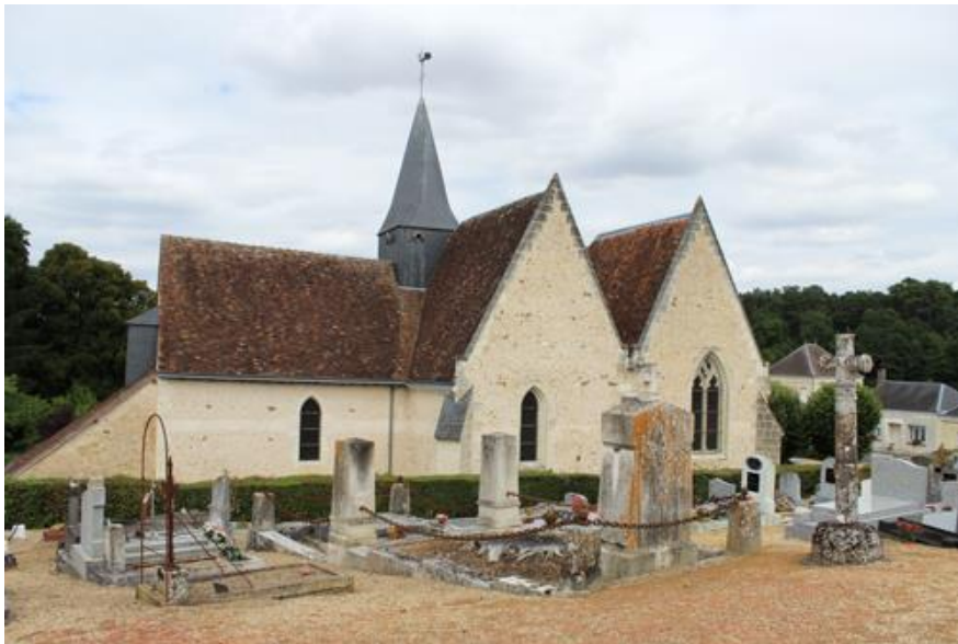
L'église paroissiale de Fontaine.
