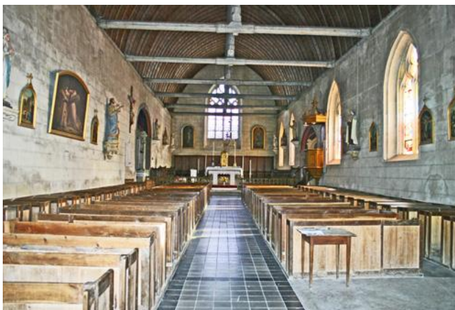
La nef de l'église de Sougé et sa charpente contemporaine de Ronsard
