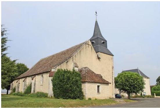
L'église paroissiale de Villerable.
