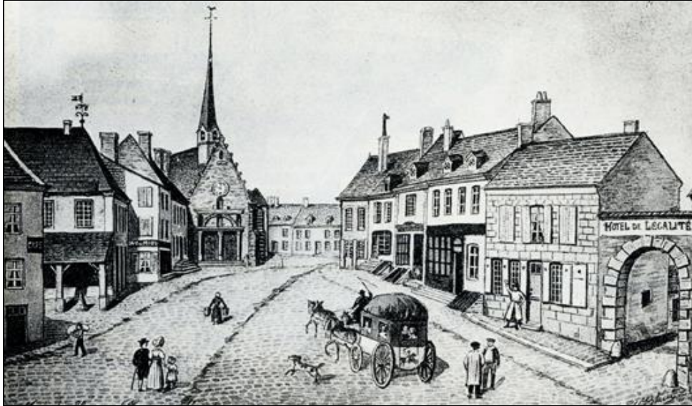
Au cœur de Mondoubleau, non loin de la halle et de l'église, le porche donnant accès au local du District.
