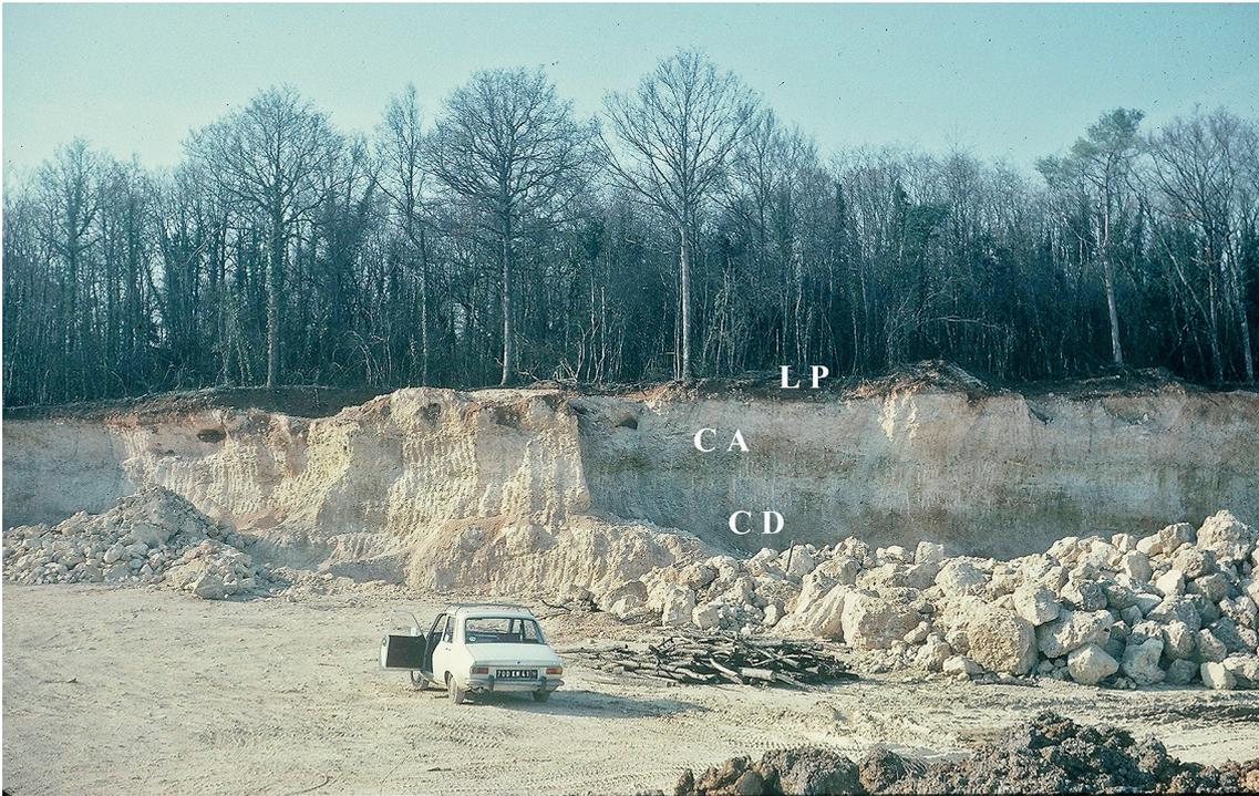
**Fig. 1 :** Landes-le-Gaulois, carrière du Buisson-Sabotier. Vue de la partie occidentale du front de taille est-ouest en cours d'exploitation en 1971 par l'entreprise Hernandez. La couverture limoneuse (LP) est découpée jusqu'au calcaire altéré (CA); le calcaire dur (CD) est exploité pour la construction (cl. J. Despriée).
