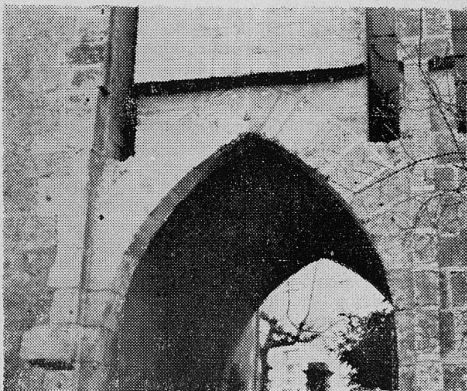
Vue du côté du Loir, la Porte laisse nettement apparaître les logements, dans la pierre, du tablier du pont-levis dans sa position relevée
