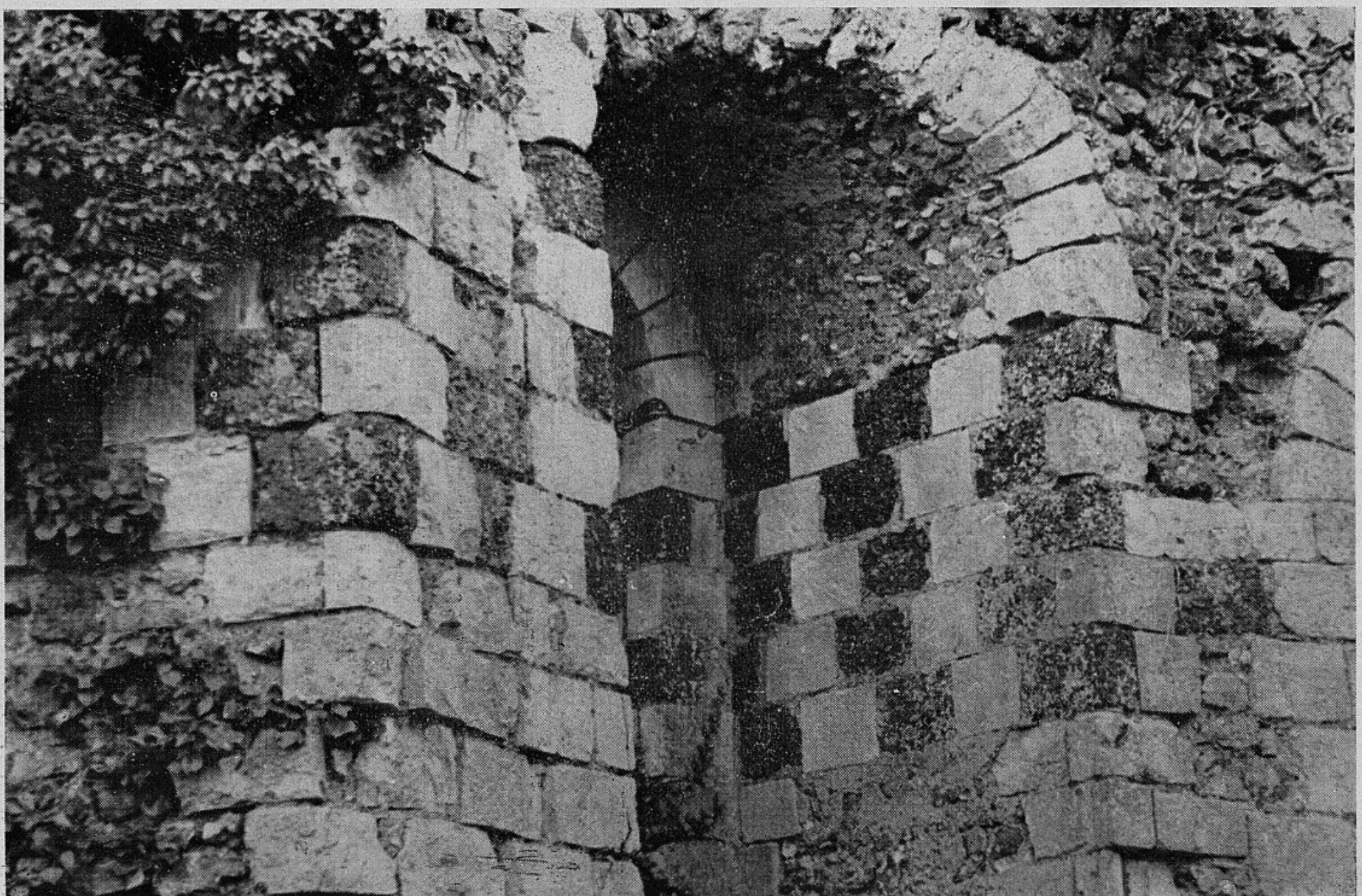
Fréteval. Intérieur du donjon. Utilisation du grès roussard en alternance de la craie de Villedieu pour obtenir un effet décoratif sur fenêtre du premier étage.
